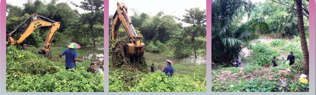
วันที่ 18 ตุลาคม 2563 เจ้าหน้าที่สำนักการช่างเทศบาลนครตรัง นำรถแบคโฮลงพื้นที่ขุดลอกผักตบชวา วัชพืชที่กีดขวางทางน้ำ เพื่อรองรับน้ำฝนและน้ำที่ไหลลงสู่คลองน้ำมุด บริเวณสวนสมเด็จพระศรีนครินทร์ 95
