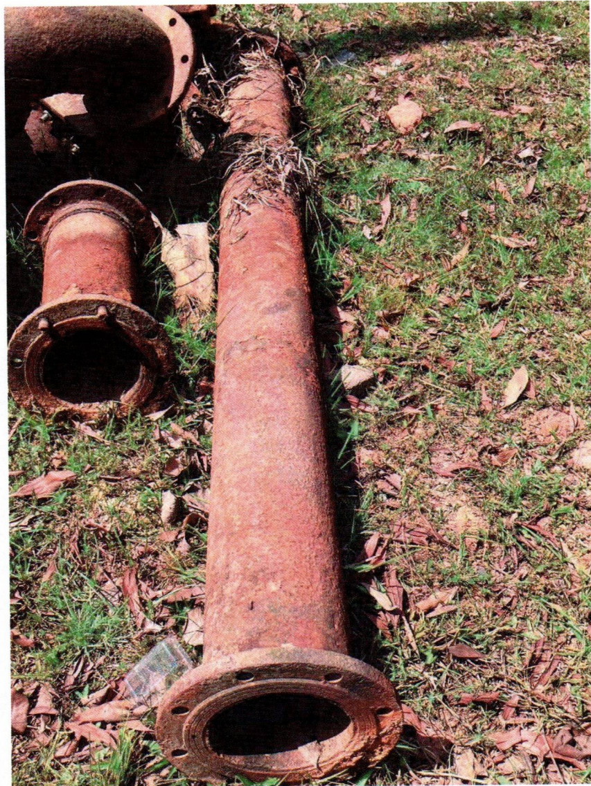
ท่อเหล็ก ท่อนที่ 2
