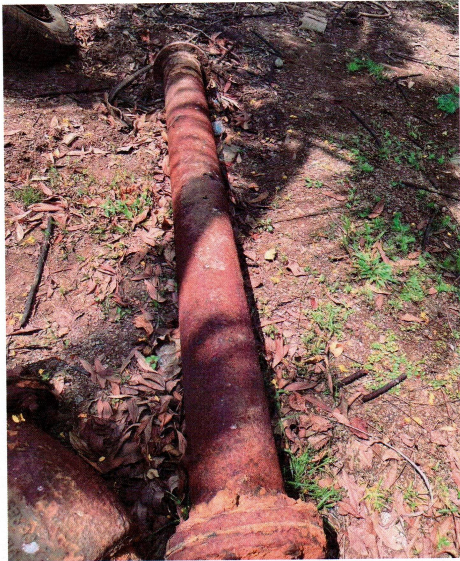
ท่อเหล็ก ท่อนที่ 3
